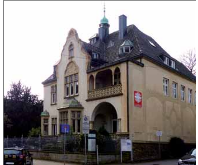
Einfriedung Bahnhofstraße 23, 2017 (Stadt Hattingen)
