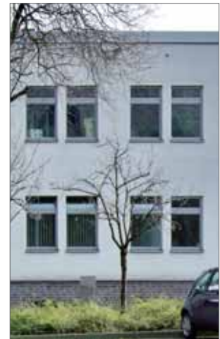
Amtsgericht, Detail der Fassade (Stadt Hattingen)
