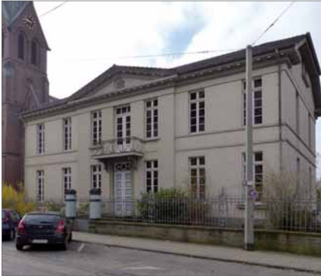
Einfriedung Bahnhofstraße 21, 2017 (Stadt Hattingen)
