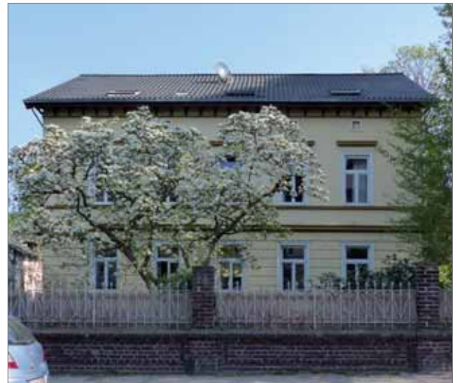
Einfriedung Bahnhofstraße 40, 2018 (Stadt Hattingen)
